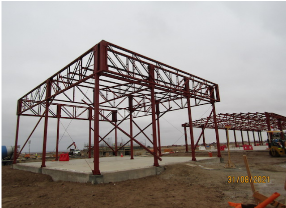
Construcción Nuevo Edificio Logístico – DGAC.
