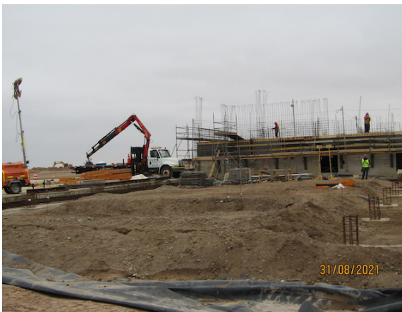
Construcción Nuevo Edificio SSEI – DGAC.
