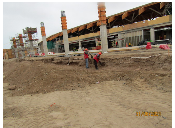
Construcción Vialidad frente Terminal de Pasajeros.
