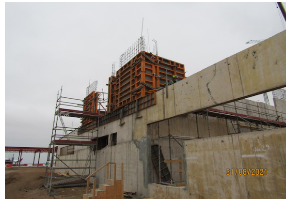
Construcción Nueva Subestación Eléctrica – DGAC.
