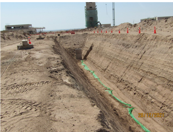
Obras de Alcantarillado – DGAC.
