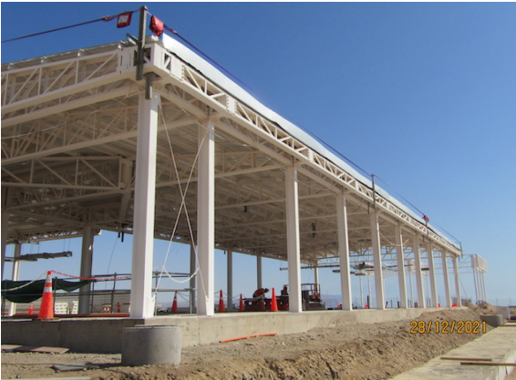
Construcción Nuevo Edificio Logístico – DGAC.
