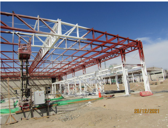
Construcción Nuevo Edificio SSEI – DGAC.
