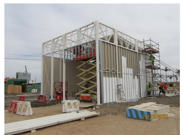
Construcción Subestación Eléctrica SC.
