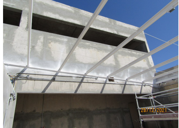
Construcción Nueva Subestación Eléctrica – DGAC.
