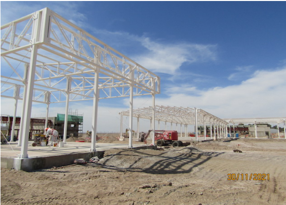
Construcción Nuevo Edificio Logístico – DGAC.
