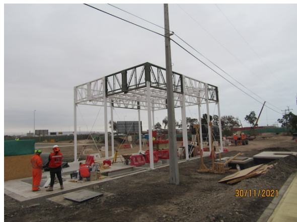
Construcción Subestación Eléctrica SC.
