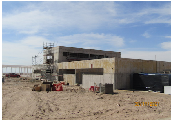
Construcción Nueva Subestación Eléctrica – DGAC.
