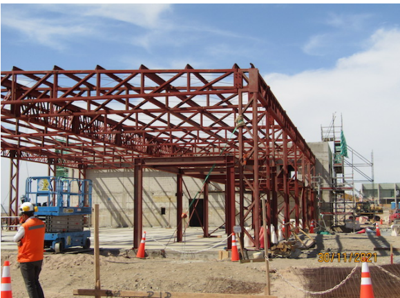
Construcción Nuevo Edificio SSEI – DGAC.
