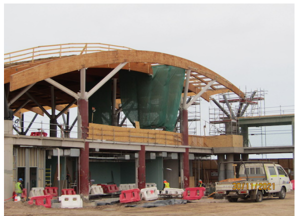
Ampliación Terminal de Pasajeros.
