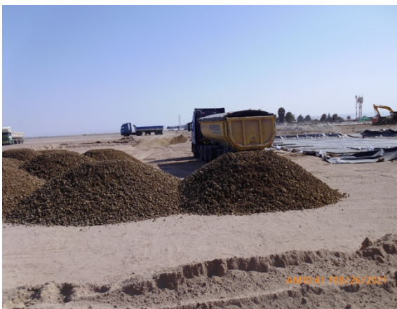
Construcción Nuevo Edificio SSEI – DGAC.
