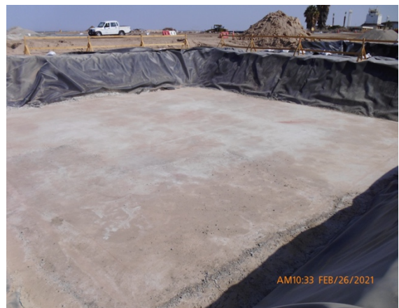
Construcción Nueva Torre de Control – DGAC.
