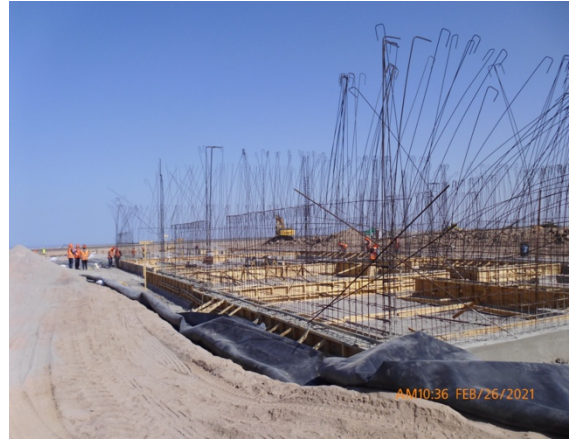
Construcción Nueva Subestación Eléctrica – DGAC.
