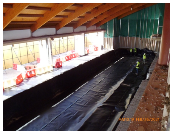
Ampliación Terminal de Pasajeros.
