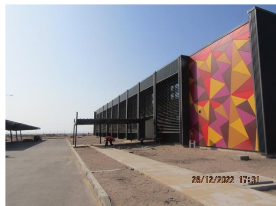
Construcción Edificio Administrativo.
