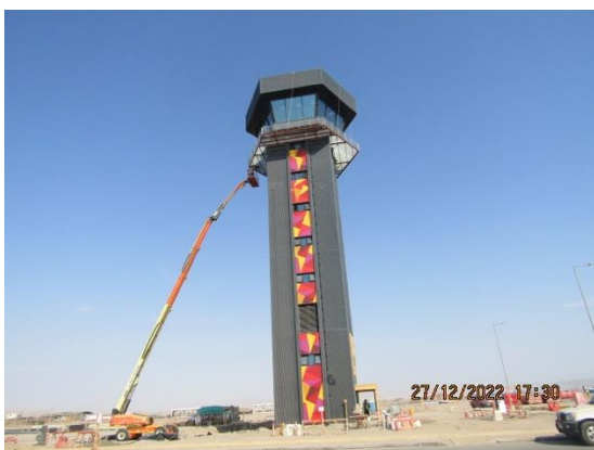
Nueva Torre de Control.
