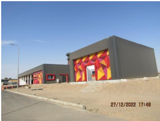
Construcción Nuevo Edificio Logístico – DGAC.
