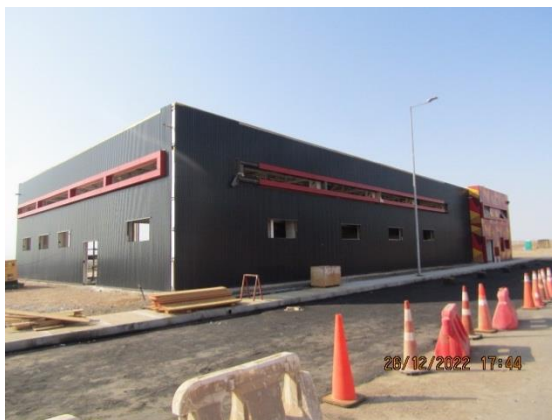
Construcción Nuevo Edificio SSEI – DGAC.
