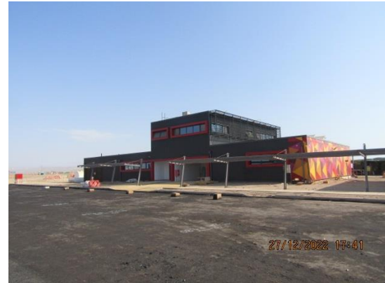
Construcción Nueva Subestación Eléctrica – DGAC.
