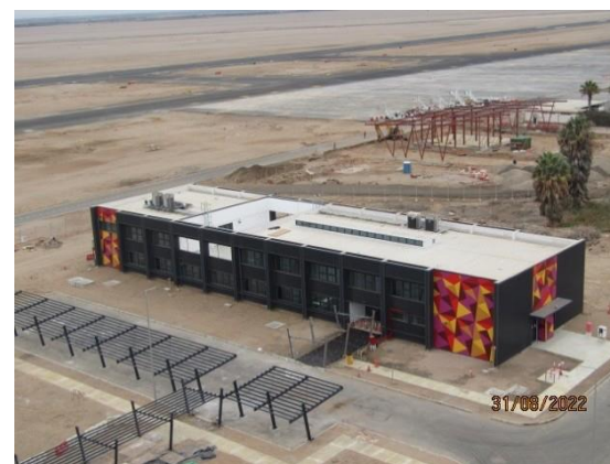
Construcción Edificio Administrativo.
