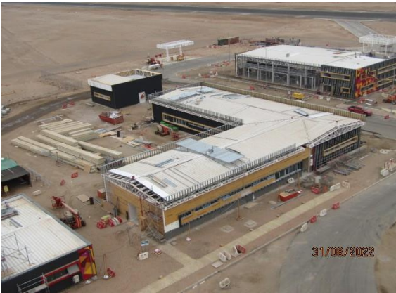
Construcción Nuevo Edificio Logístico – DGAC.
