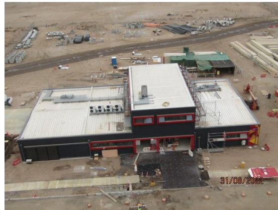
Construcción Nueva Subestación Eléctrica – DGAC.
