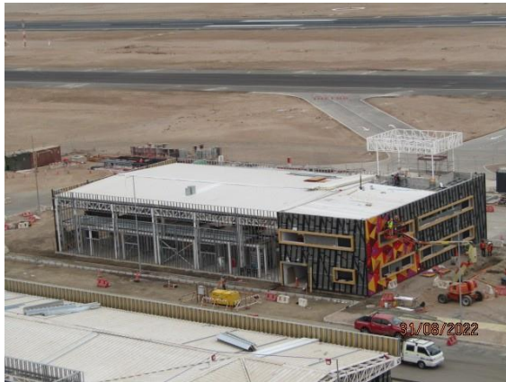
Construcción Nuevo Edificio SSEI – DGAC.
