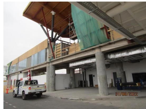
Ampliación Terminal de Pasajeros.
