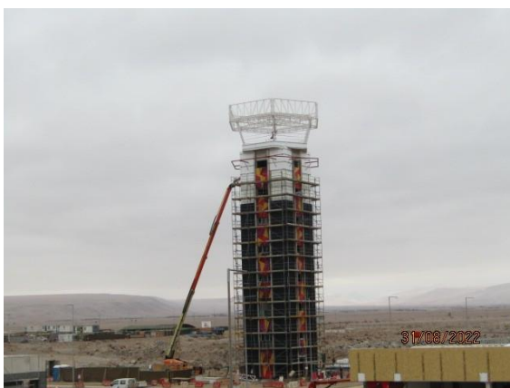
Nueva Torre de Control.
