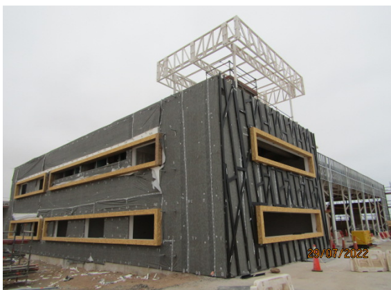
Construcción Nuevo Edificio SSEI – DGAC.
