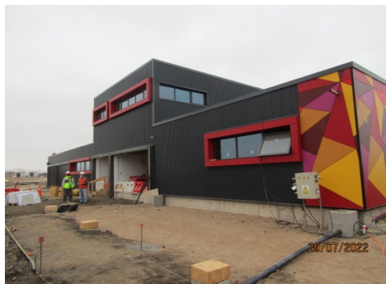
Construcción Nueva Subestación Eléctrica – DGAC.
