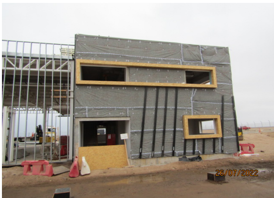
Construcción Nuevo Edificio Logístico – DGAC.
