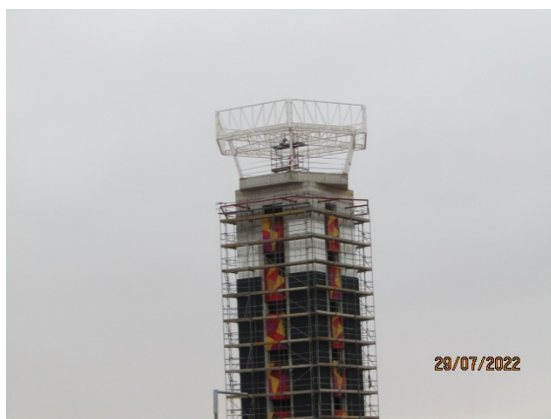
Nueva Torre de Control.
