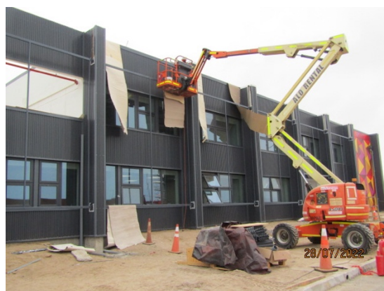
Construcción Edificio Administrativo.
