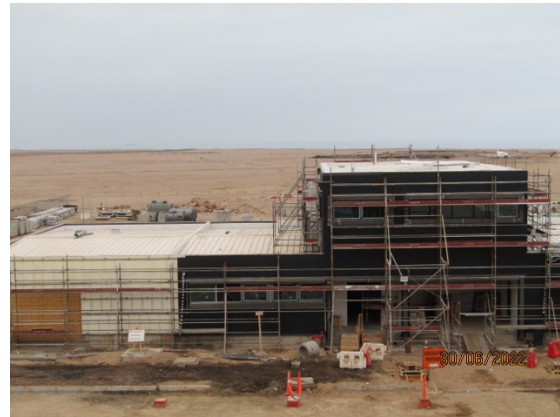
Construcción Nueva Subestación Eléctrica – DGAC.
