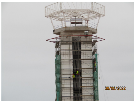
Nueva Torre de Control.
