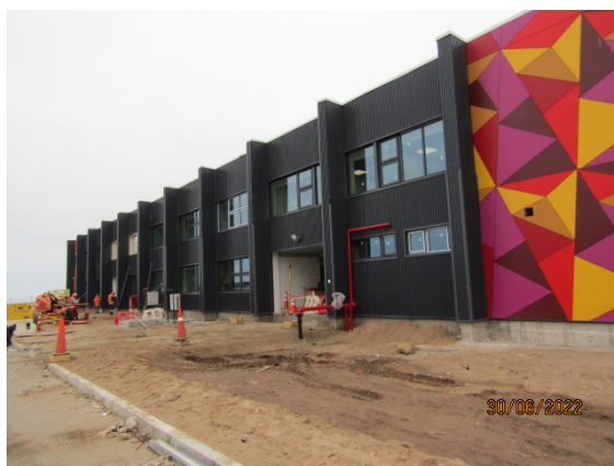
Construcción Edificio Administrativo.
