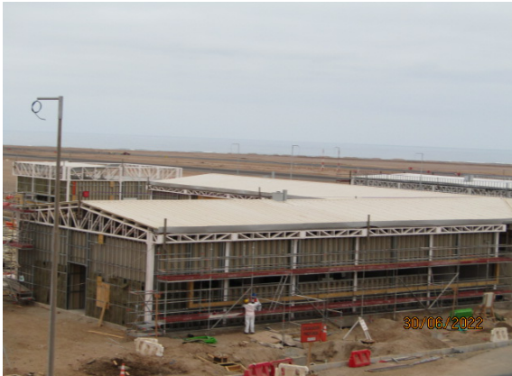
Construcción Nuevo Edificio Logístico – DGAC.
