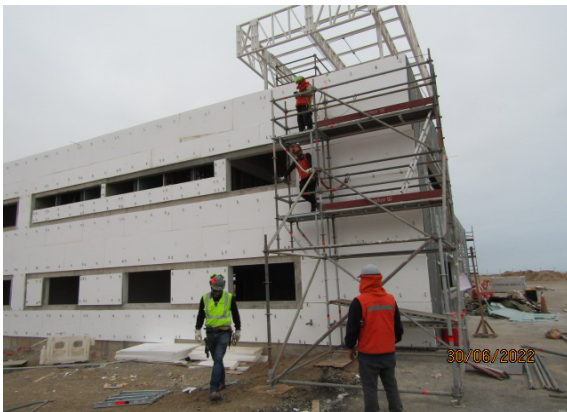
Construcción Nuevo Edificio SSEI – DGAC.
