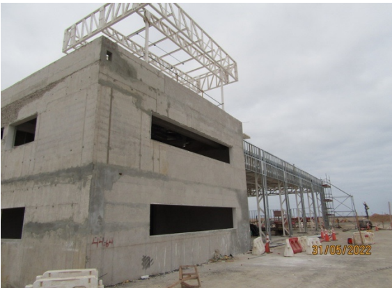
Construcción Nuevo Edificio SSEI – DGAC.
