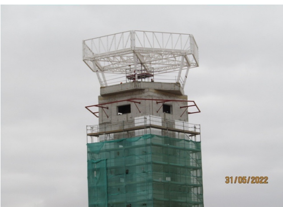
Nueva Torre de Control.
