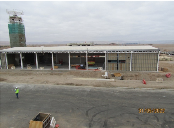
Construcción Nuevo Edificio Logístico – DGAC.
