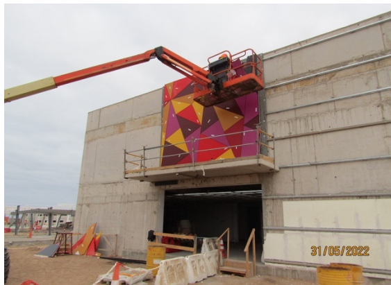
Construcción Edificio Administrativo.
