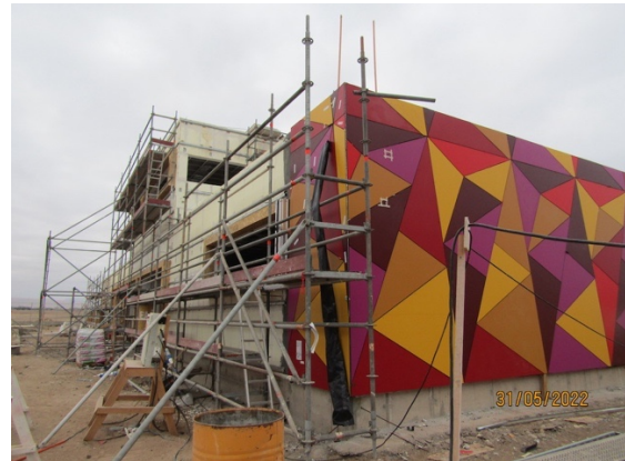
Construcción Nueva Subestación Eléctrica – DGAC.
