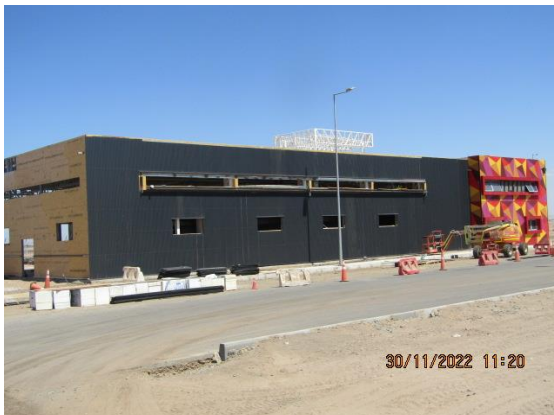
Construcción Nuevo Edificio SSEI – DGAC.
