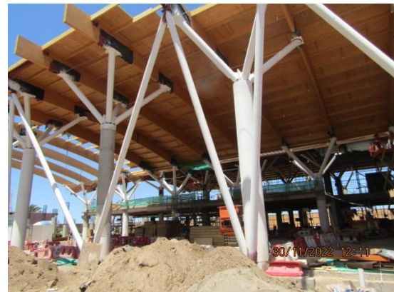
Ampliación Terminal de Pasajeros.
