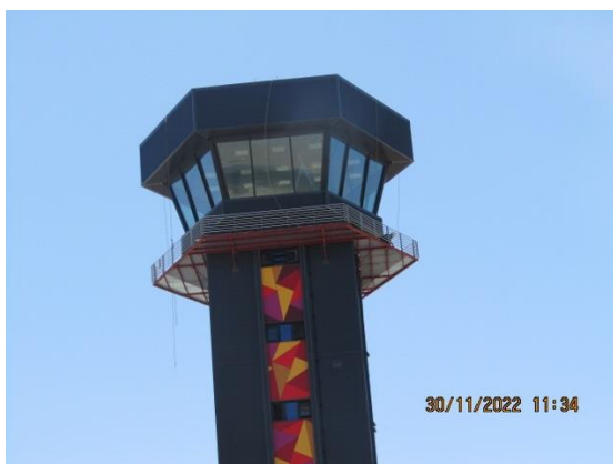
Nueva Torre de Control.
