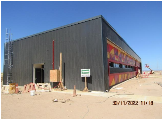
Construcción Nuevo Edificio Logístico – DGAC.
