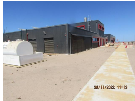
Construcción Nueva Subestación Eléctrica – DGAC.
