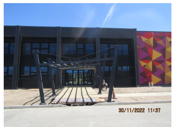
Construcción Edificio Administrativo.
