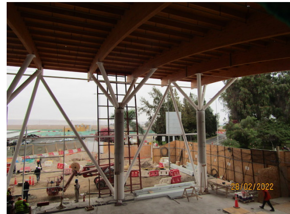
Ampliación Terminal de Pasajeros.
