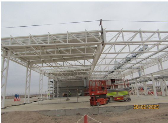
Construcción Nuevo Edificio SSEI – DGAC.
