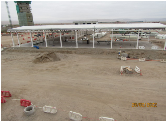
Construcción Nuevo Edificio Logístico – DGAC.
