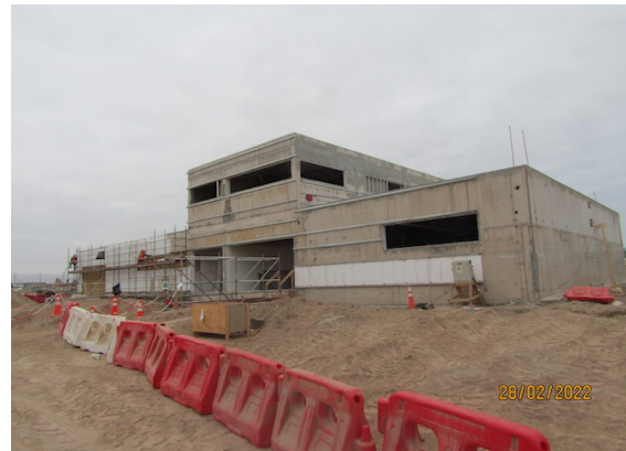
Construcción Nueva Subestación Eléctrica – DGAC.
