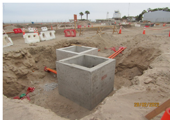
Banco de ductos – DGAC.
