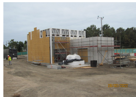
Construcción Subestación Eléctrica SC.
