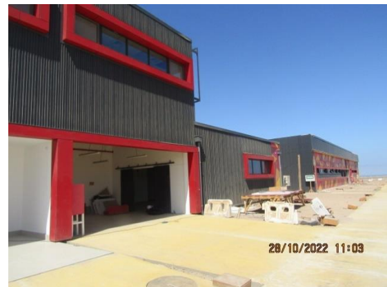
Construcción Nueva Subestación Eléctrica – DGAC.
