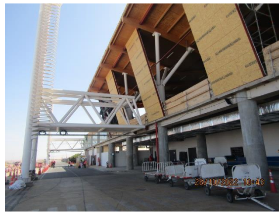
Ampliación Terminal de Pasajeros.
