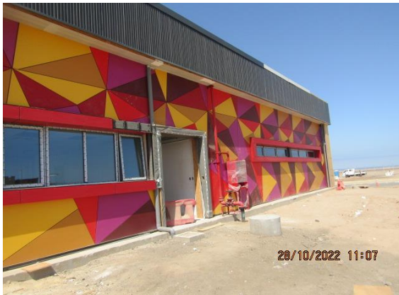
Construcción Nuevo Edificio Logístico – DGAC.
