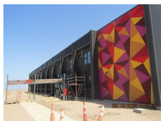
Construcción Edificio Administrativo.
