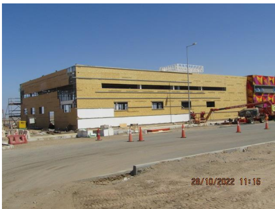
Construcción Nuevo Edificio SSEI – DGAC.
