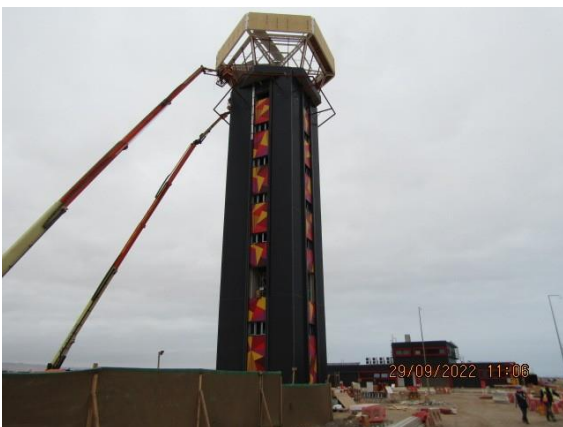
Nueva Torre de Control.
