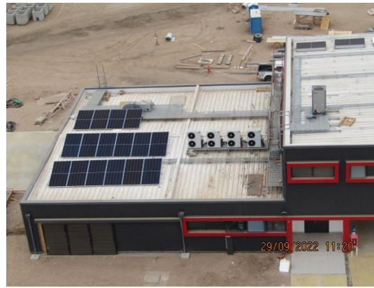
Construcción Nueva Subestación Eléctrica – DGAC.
