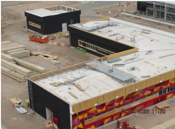
Construcción Nuevo Edificio Logístico – DGAC.
