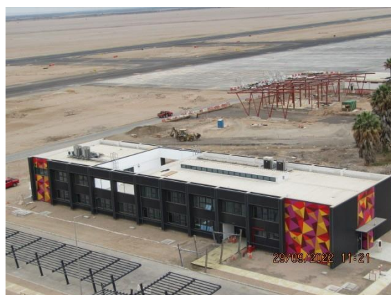
Construcción Edificio Administrativo.
