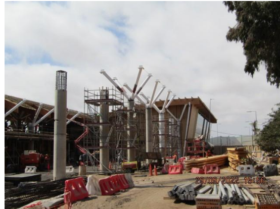
Ampliación Terminal de Pasajeros.
