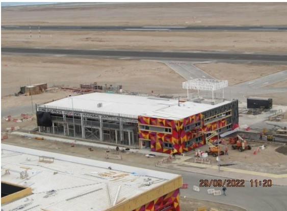
Construcción Nuevo Edificio SSEI – DGAC.
