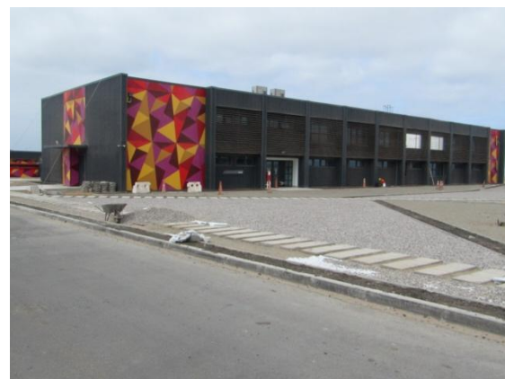
Construcción Edificio Administrativo.
