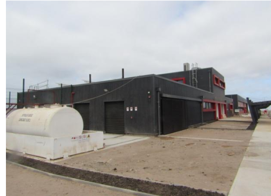
Construcción Nueva Subestación Eléctrica – DGAC.
