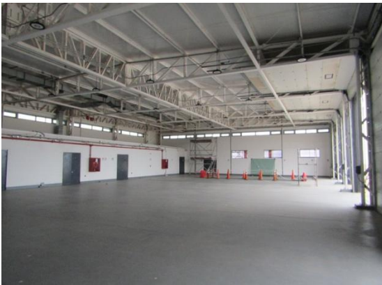
Construcción Nuevo Edificio SSEI – DGAC.
