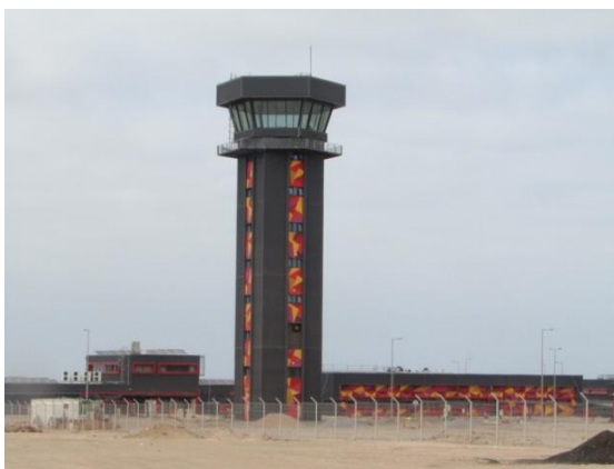
Nueva Torre de Control.
