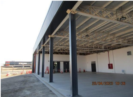
Construcción Nuevo Edificio Logístico – DGAC.
