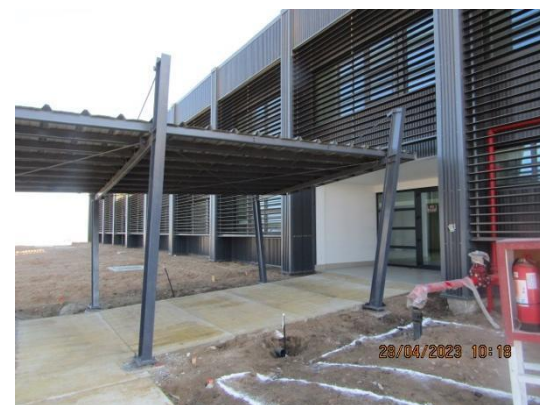
Construcción Edificio Administrativo.
