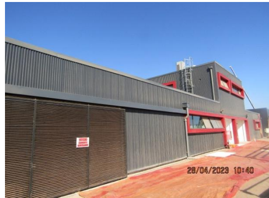
Construcción Nueva Subestación Eléctrica – DGAC.
