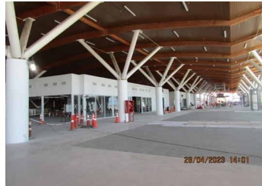
Ampliación Terminal de Pasajeros.
