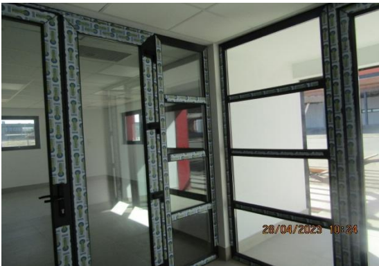
Construcción Nuevo Edificio SSEI – DGAC.
