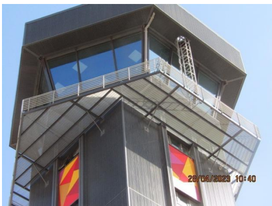
Nueva Torre de Control.
