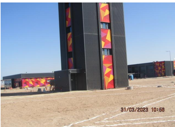
Nueva Torre de Control.
