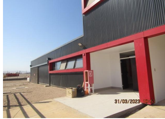
Construcción Nueva Subestación Eléctrica – DGAC.
