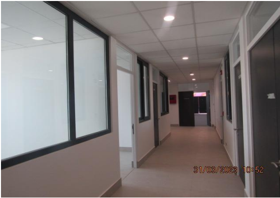
Construcción Nuevo Edificio Logístico – DGAC.
