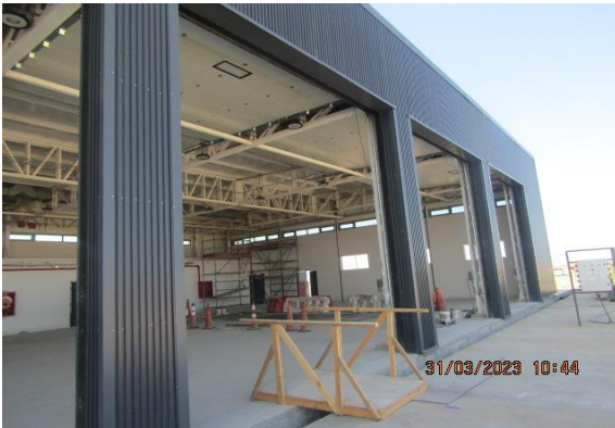
Construcción Nuevo Edificio SSEI – DGAC.
