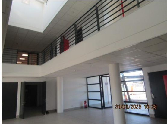
Construcción Edificio Administrativo.
