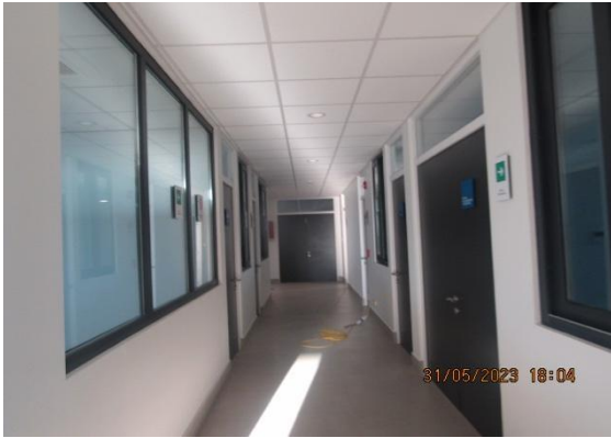
Construcción Nuevo Edificio Logístico – DGAC.
