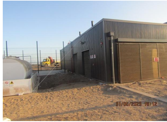
Construcción Nueva Subestación Eléctrica – DGAC.
