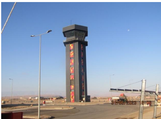
Nueva Torre de Control.
