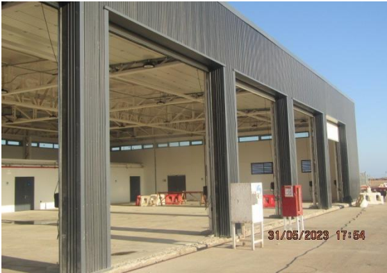
Construcción Nuevo Edificio SSEI – DGAC.
