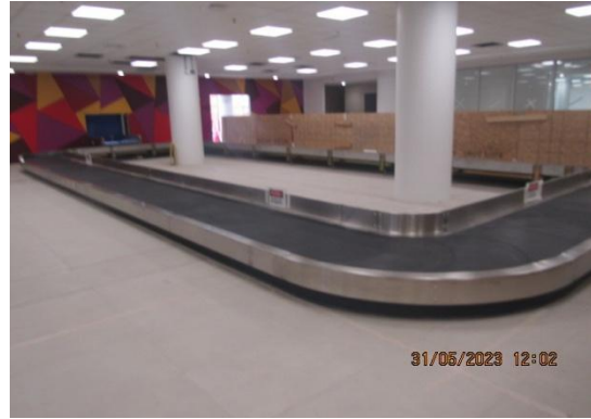
Ampliación Terminal de Pasajeros.
