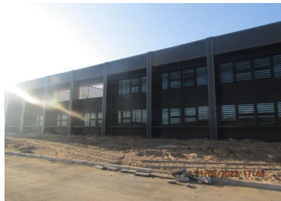
Construcción Edificio Administrativo.
