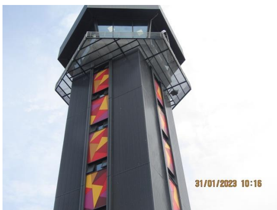
Nueva Torre de Control.
