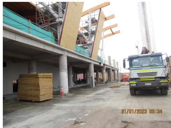
Ampliación Terminal de Pasajeros.
