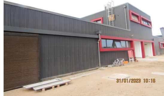
Construcción Nueva Subestación Eléctrica – DGAC.
