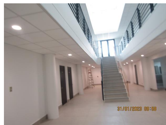
Construcción Edificio Administrativo.
