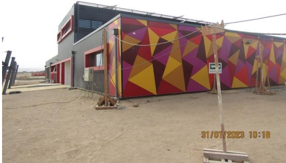
Construcción Nuevo Edificio Logístico – DGAC.
