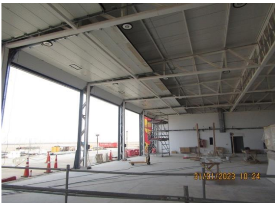
Construcción Nuevo Edificio SSEI – DGAC.
