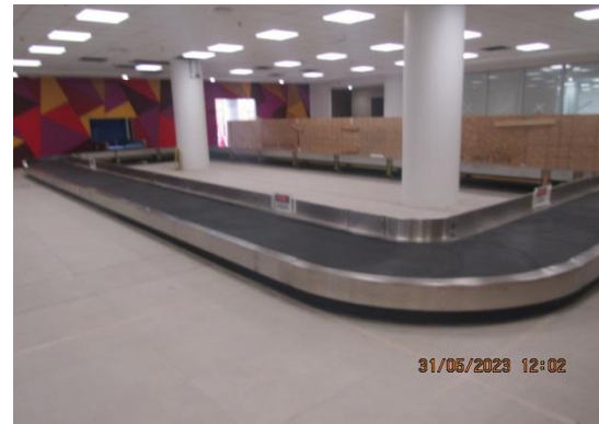
Ampliación Terminal de Pasajeros.
