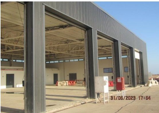
Construcción Nuevo Edificio SSEI – DGAC.
