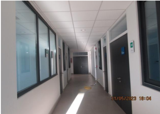
Construcción Nuevo Edificio Logístico – DGAC.
