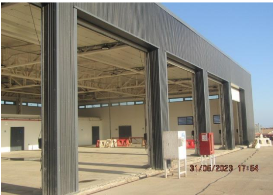
Construcción Nuevo Edificio SSEI – DGAC.
