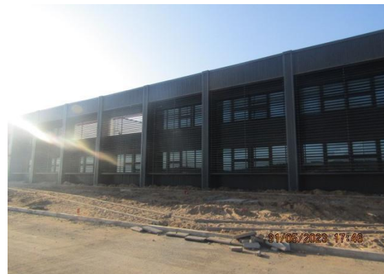
Construcción Edificio Administrativo.
