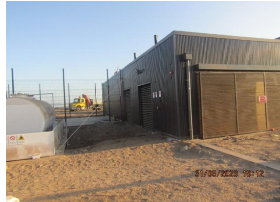
Construcción Nueva Subestación Eléctrica – DGAC.
