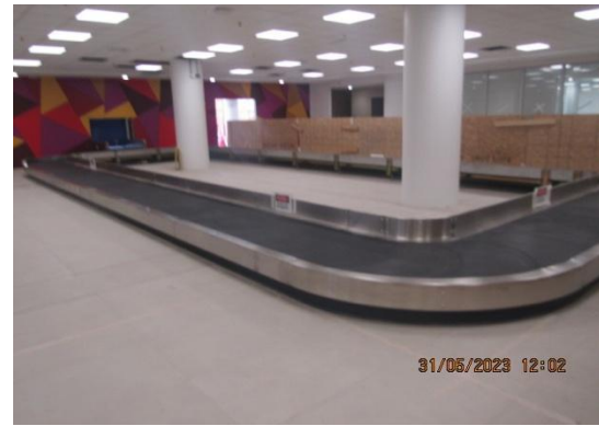
Ampliación Terminal de Pasajeros.
