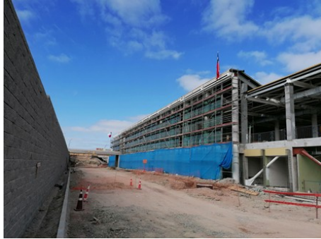
Estructuración Muro Cortinado Fachada Edificio PAX
