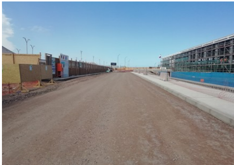
Base Compactada Calle Piso 2
