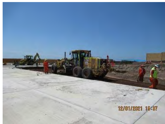
Colocación Base Estabilizada Lotes 1,2,3 4 y 5, Plataforma Norte
