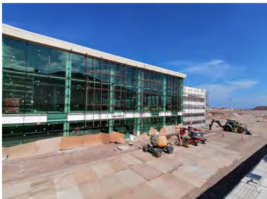
Instalación de Perfilería Base de Celosías, Fachada, Edificio Terminal de Pasajeros
