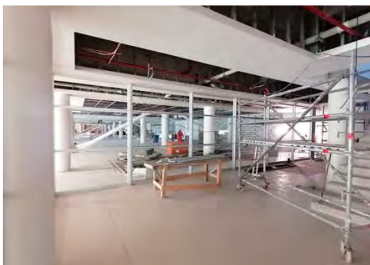
Instalación Tabiquerías Vidriadas, 1° y 2° Nivel, Edificio Terminal de Pasajeros (Ampliación)
