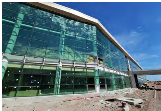
Remates Muro Cortina Fachada (Ampliación)
