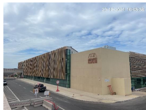
Vista Sector Ampliación Terminal de Pasajeros
