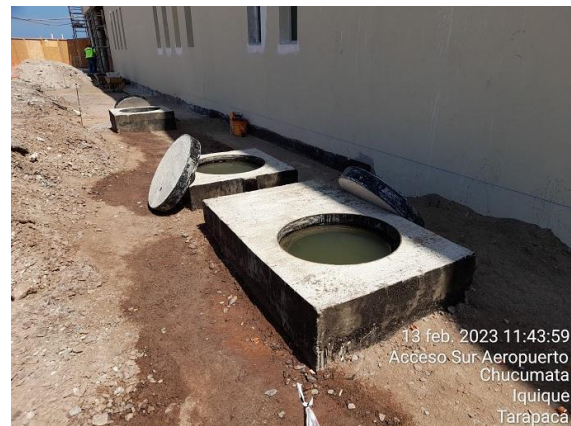
Pruebas de Estanquidad Cámaras Alcantarillado
