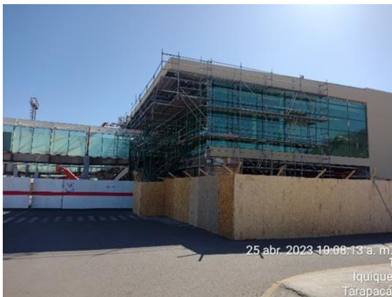
Ejecución de Cubiertas faltantes en Sur poniente
