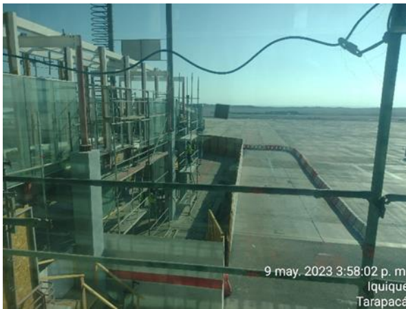
Cierros y mitigaciones para trabajos en Puente Embarque N°2
