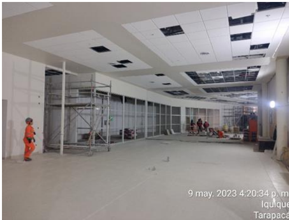
Avance Terminaciones sector Counters Piso 2
