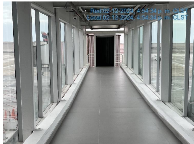
Mantención Puentes de Embarque.
