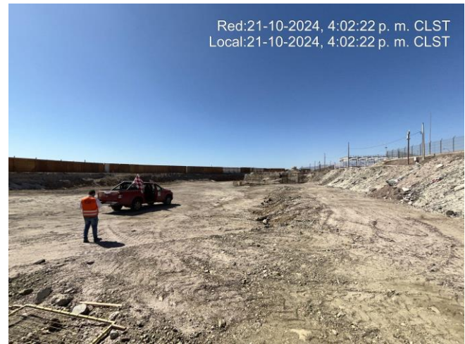
Trabajos Plataforma “Faseado” sin avance
