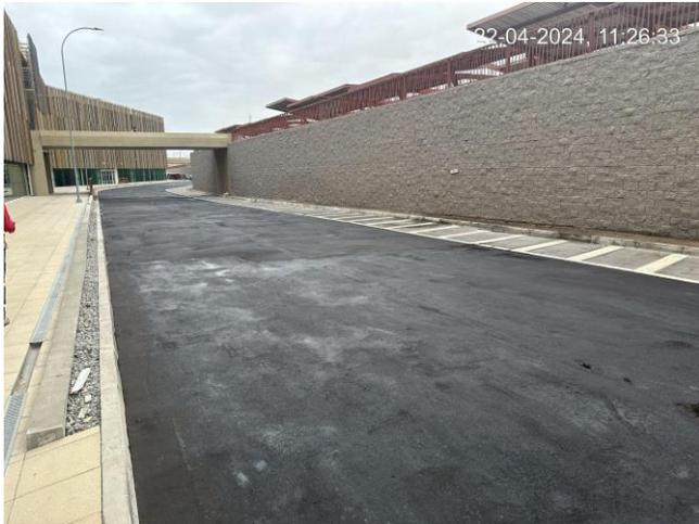
Aplicación de lechada Asfáltica sobre pavimento en sector Calle 1.
