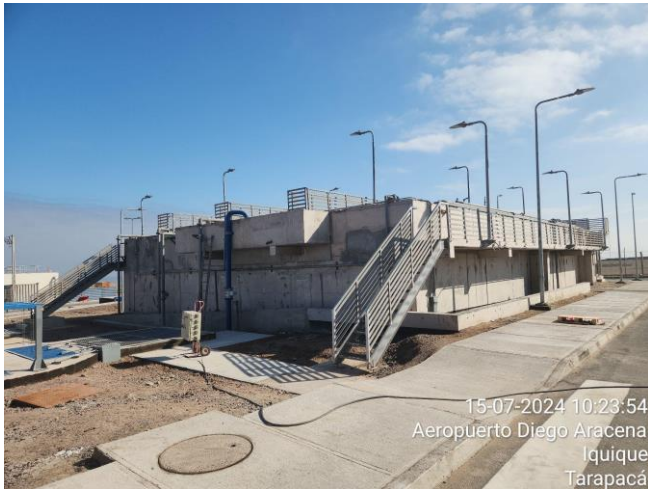
Planta de Tratamiento de Aguas Servidas
