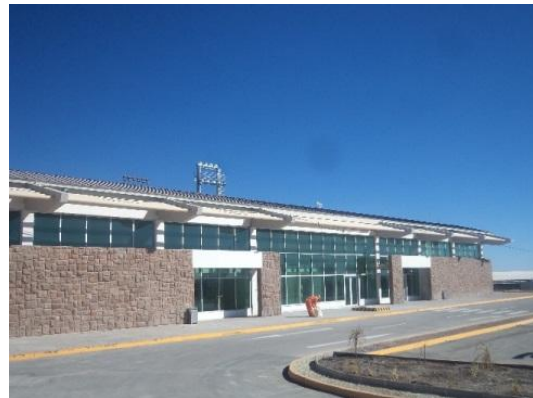
(10) Edificio Logístico DGAC
