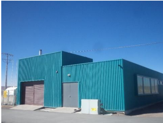
(7) Sub Estación DGAC
