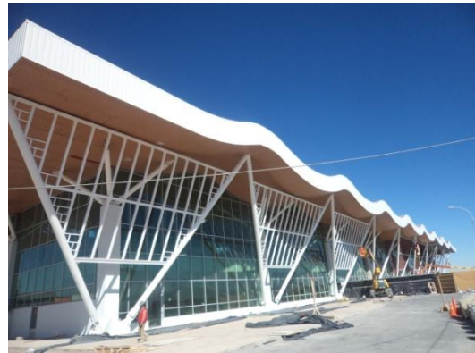
(2) Frontis Edificio Terminal (Zona Terrestre) 02
