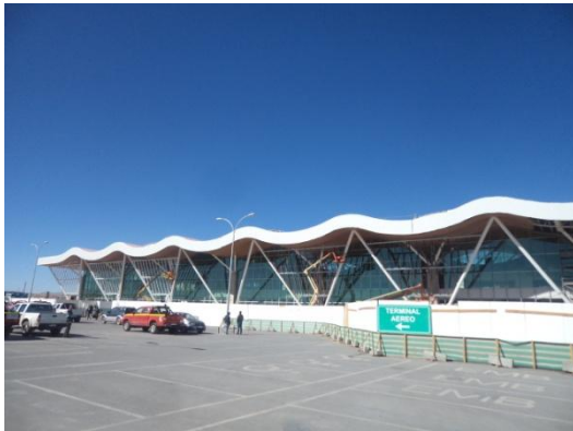
(1) Frontis Edificio Terminal (Zona Terrestre) 01
