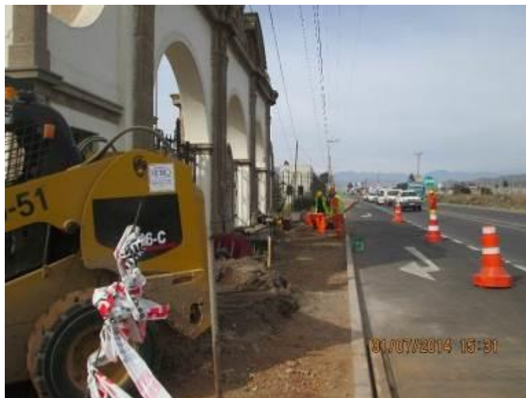
Foto N° 03 Vista de Pista de desaceleración, Ruta 41.
