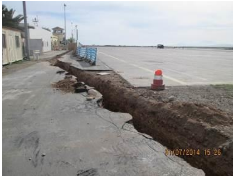
Foto N°05 Vista trabajos de excavación de Red Húmeda.
