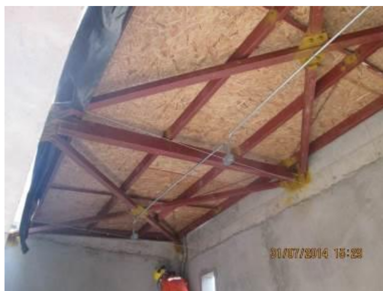
Foto N°04 Vista interior de Sala de Basuras
