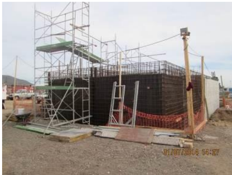
Foto N°10 Avance de Sala de bombas y Estanques.
