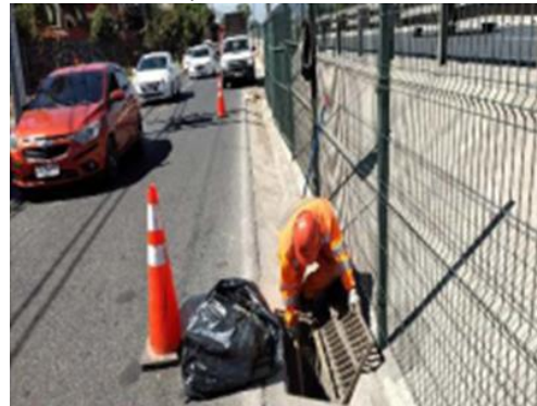
Limpieza de Sumideros.
