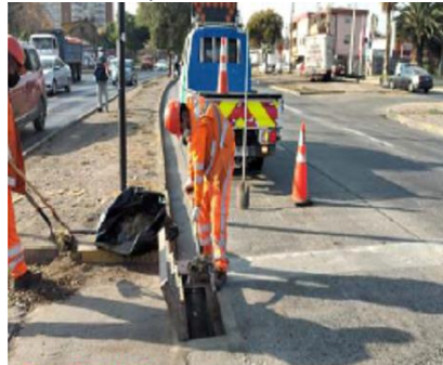
Limpeza de Sumideros
