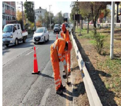
Limpeza de Cunetas y Soleras.
