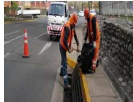
Limpieza de Sumideros
