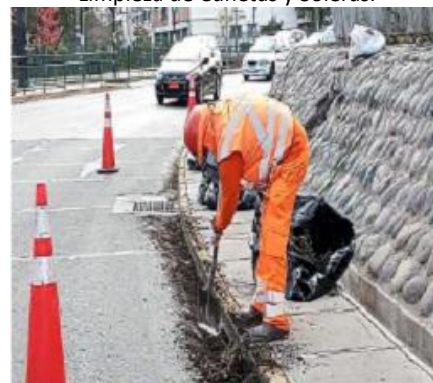
Limpieza de Cunetas y Soleras.
