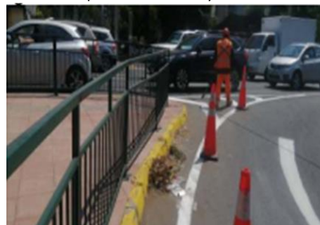
Limpieza de Cunetas y Soleras.
