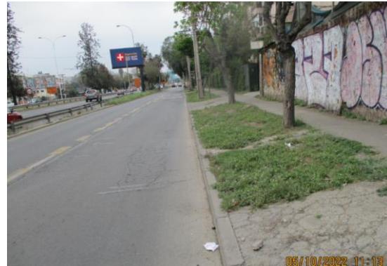
Limpeza de calzadas.
