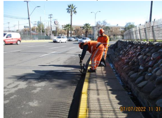
Limpieza de Cunetas y Soleras.
