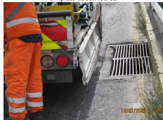
Limpieza de sumideros.
