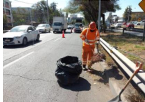
Limpeza de sumideros.
