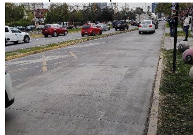
Reparación de pavimentos
