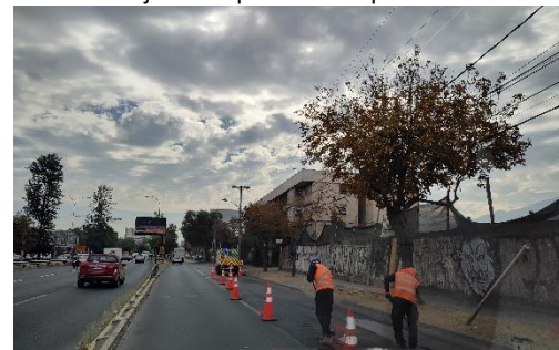
Trabajos de reparación de pavimentos
