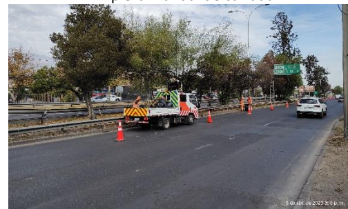
Limpieza manual de calzada
