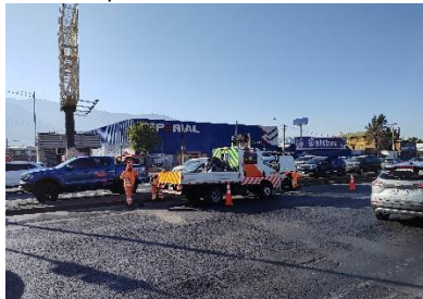
Limpieza manual de calzada
