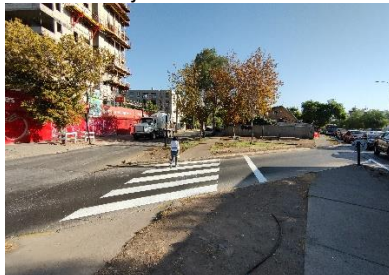
Trabajos de demarcación
