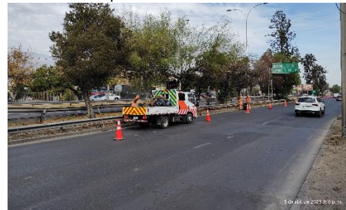
Limpieza manual de calzada
