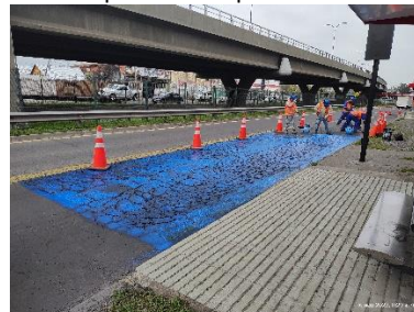
Reparación de pavimentos
