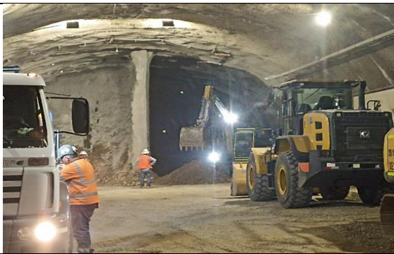
Túnel Híbrido excavación en fases I y II
