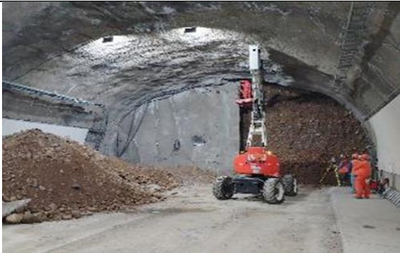
Túnel Híbrido excavación en fase I
