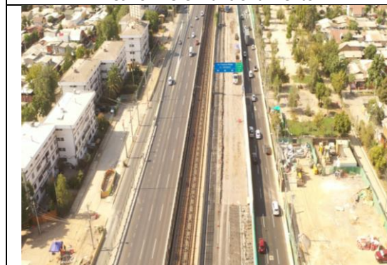
Trinchería Empalme Oriente con AVS, trabajos demolición de pavimentos
