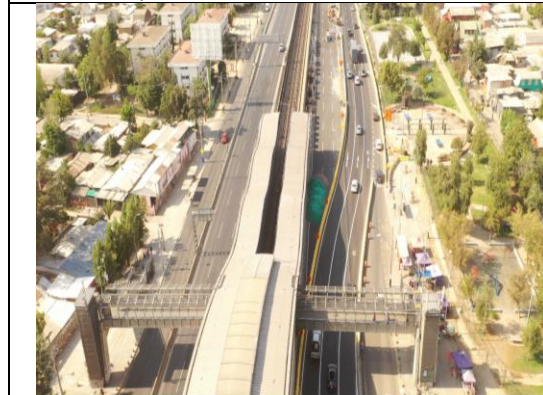
Desvío TEO en funcionamiento
