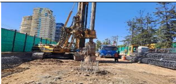
Trinchería Tobalaba Norte, ejecución Pilotes
