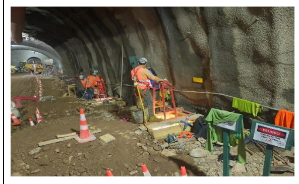
Frente 7, Túnel Híbrido, excavación pilotes para trinchera piso -2
