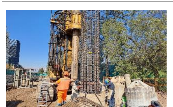
Frente 4, colocación enfierradura Pilote de refuerzo N°01
