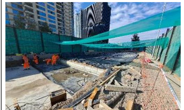
Frente 4, hormigonado del segundo tramo de losa de la Trinchera cubierta entre los Pilotes 6 y 13.
