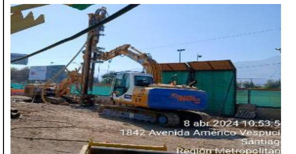
Frente 6, hincado de micropilotes para protección infraestructura Metro
