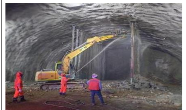
Frente 7, Túnel Híbrido demolición de muros temporales
