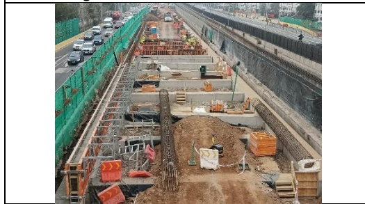
Escotilla Vespucio Sur Oriente construcción de estampadores
