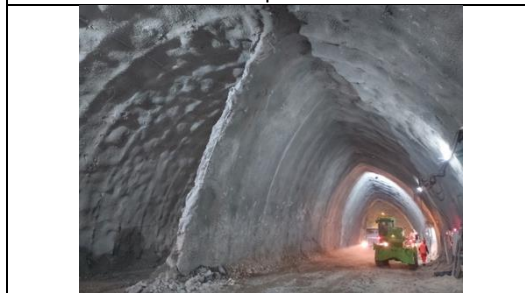
Vía expresa poniente Vía expresa avance fases 1 y 2
