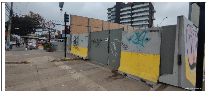
Desvío de tránsito refuerzo Caverna Blest Gana
