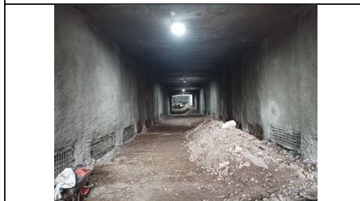
Vista general trinchera cubierta ramal STN
