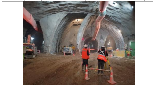
Túnel híbrido sección D, avance en fase 1 y 2
