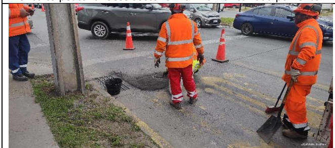
Mantenimiento pavimentos calzada poniente
