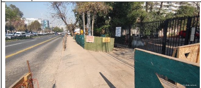
Circuito peatonal CCSS sector Simón Bolívar calzada poniente
