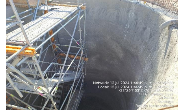
Ramal Salida Tobalaba Norte Pique sur profundidad 11,5m.
