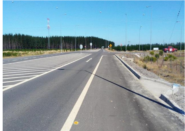
Ejecución Pista de Frenado Acceso Central Santa Lidia, Dm 7.000, Sector B
