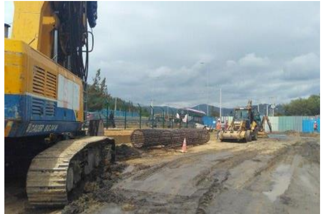
Ejecución de Pilotes Pasarela Sector Terminal Collao, Dm 72.000, Sector A
