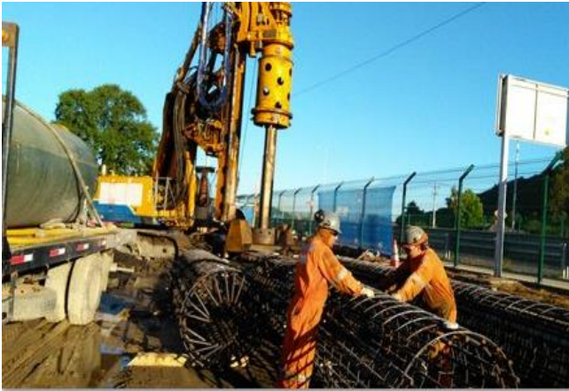
Ejecución de Pilotes Pasarela Sector Terminal Collao, Dm 72.000, Sector A
