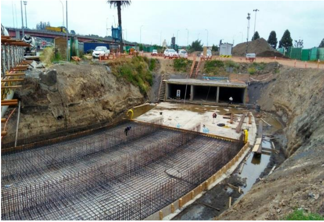
Armadura Cajón Canal Las Pocitas, Obra Adicional Soterramiento Rotonda Bonilla, Concepción
