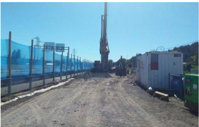
Ejecución de Pilotes Pasarela Sector El Membrillo, Dm 19.500, Sector A
