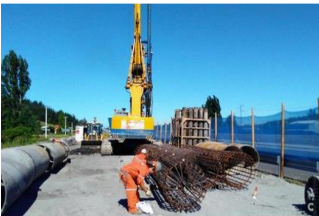
Ejecución de Pilotes Pasarela Sector El Membrillo, Dm 19.500, Sector A
