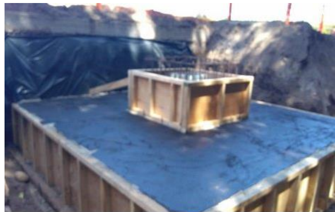
Ejecución de Fundaciones Pasarela Sector Puente Ibáñez, Dm 13.720, Sector A
