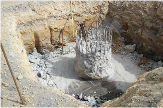
Ejecución de Pilotes Pasarela Sector Puente San Antonio, Dm 55.370, Sector A
